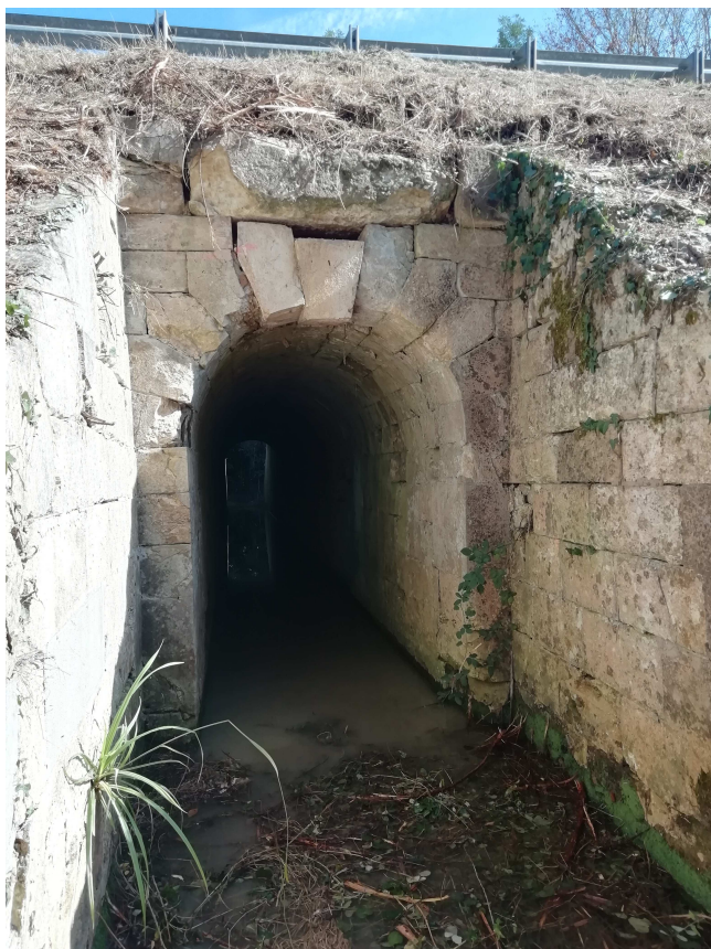
État actuel du pont de Biran
